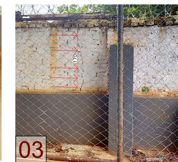
IMAGENS DOS ELEMENTOS A SEREM TRATADOS DE FISSURAS COM GRAMPEAMENTO SEM ESCALA
