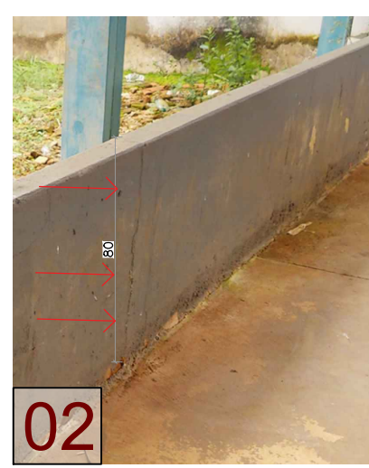
IMAGENS DOS ELEMENTOS A SEREM TRATADOS DE FISSURAS COM GRAMPEAMENTO SEM ESCALA
