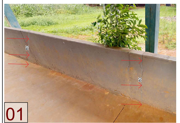
IMAGENS DOS ELEMENTOS A SEREM TRATADOS DE FISSURAS COM GRAMPEAMENTO SEM ESCALA
